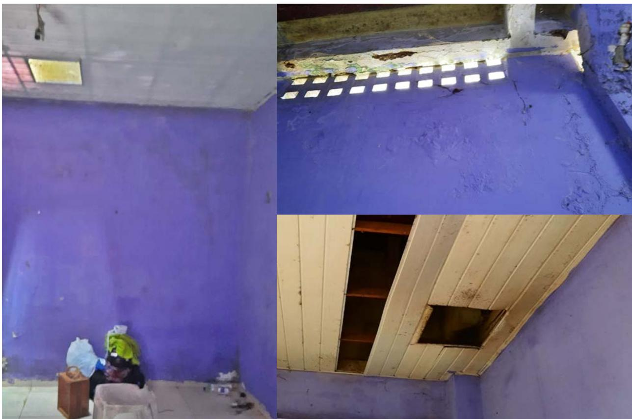
Il n'y a aucun confort. Les murs sont délabrés et humides. L'eau s'infiltré par le toit et inonde toutes les affaires posées à même le sol.
